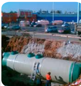
Odlučovač lehkých kapalin GRP o výkonu 135 l/s na periferii Karlových Varů (Česká republika)
