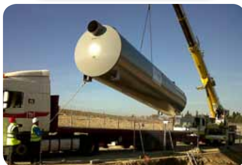
Ocelový odlučovač oleje o výkonu 600 l/s – továrna Peugeot v Etupes (FR-25)
