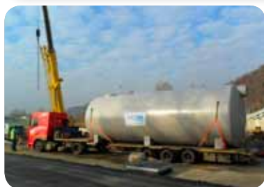
Praha Tunel Blanka, (Česká republika)
