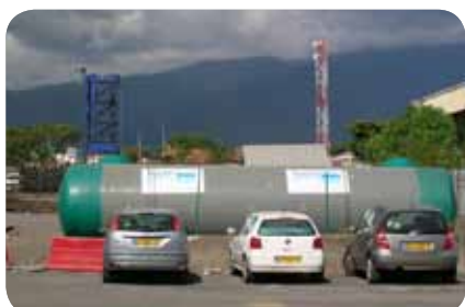
Odlučovače oleje GRP ve vnitřním přístavu – ostrov Réunion (FR-97)
