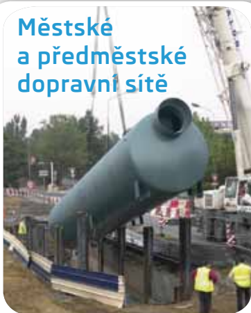
Ocelový odlučovač oleje o výkonu 200 l/s na periferii Toulouse (FR-31)
